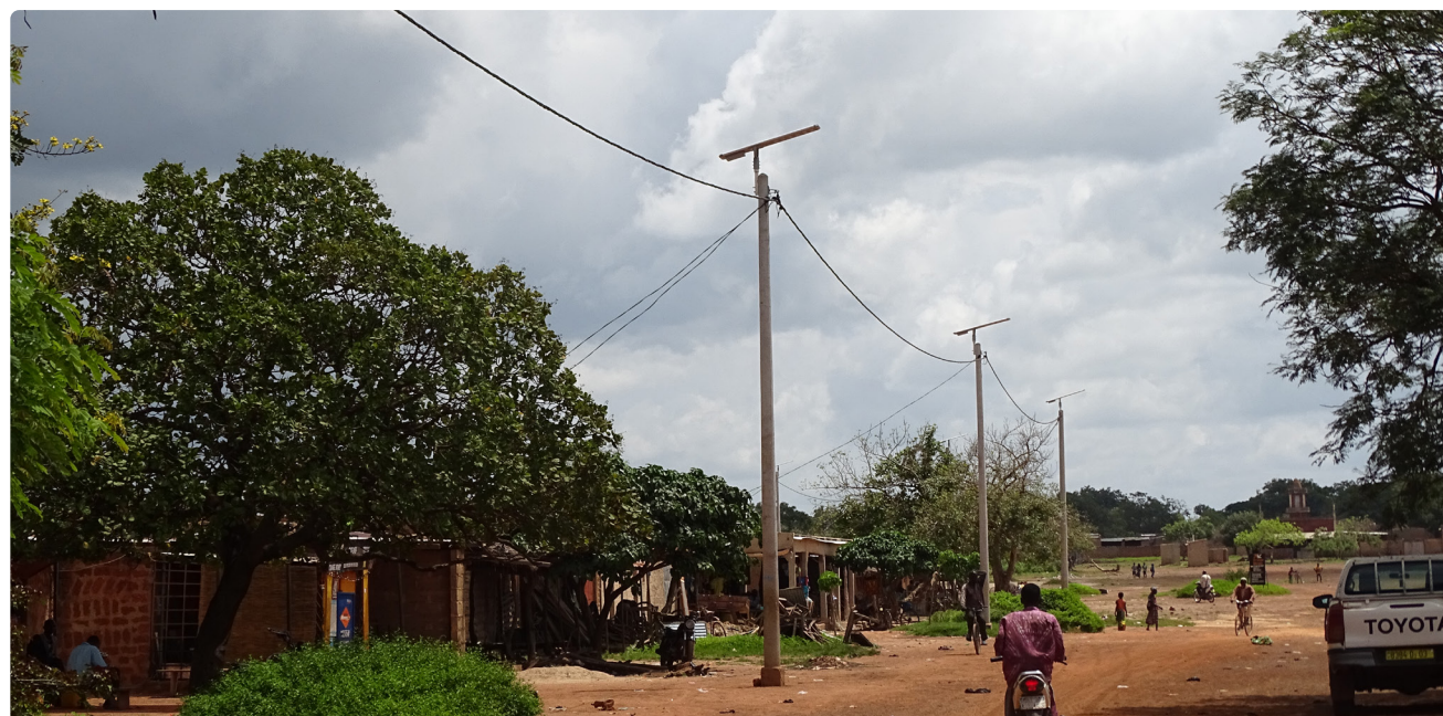
Électrification rurale dans le village de Kouakoualé, alimentée par FRES
